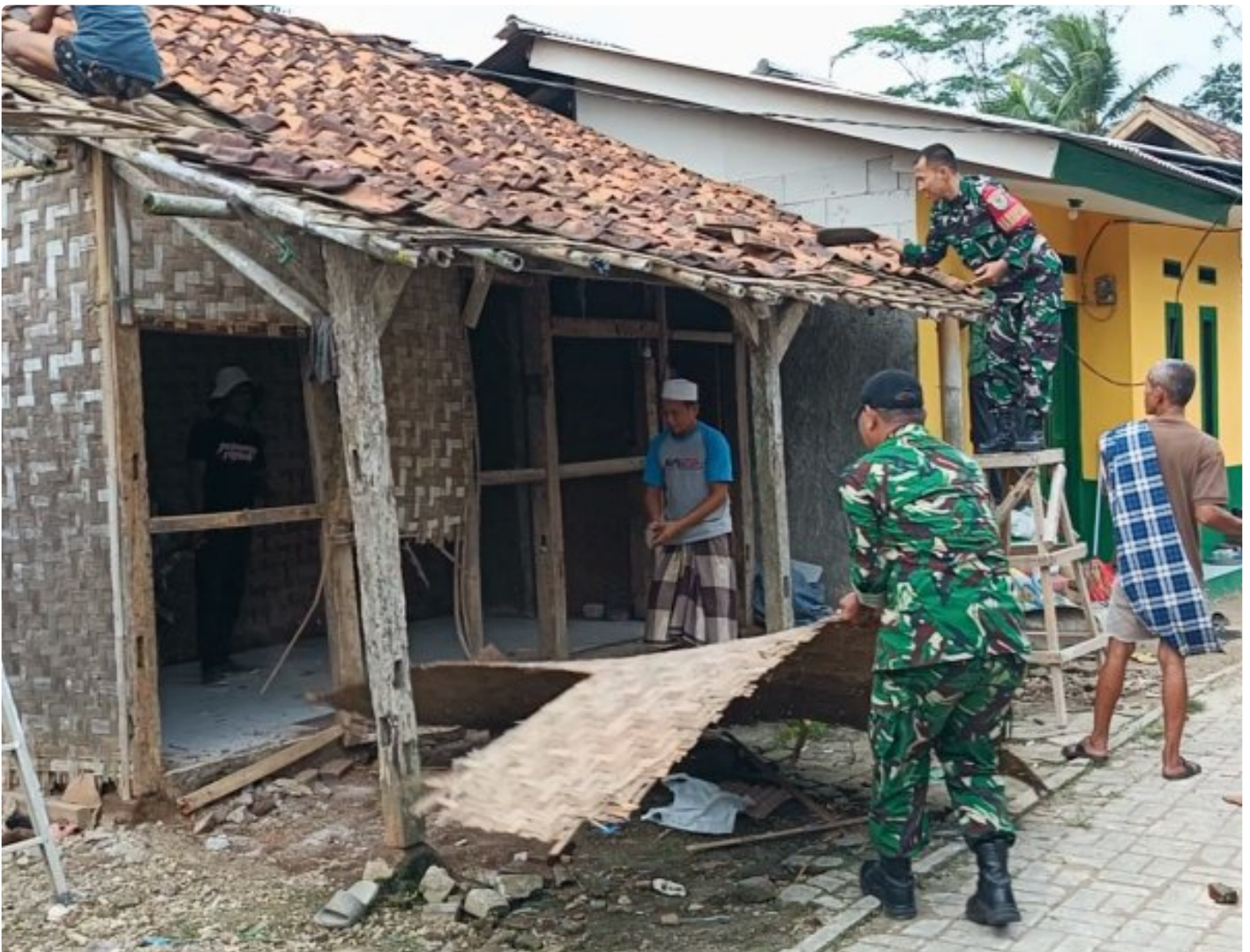
Pembongkaran Rumah Bapak Narmin
